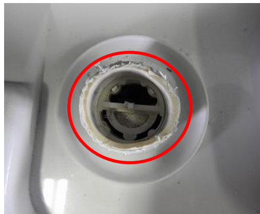
②洗濯機の給水口の変形
